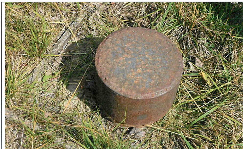
Zdjęcie 7 – Piezometr obserwacyjny znajdujący się na czaszy składowiska odpadów.
